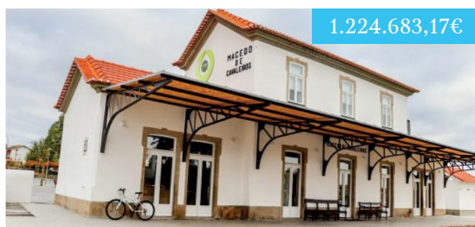
Reabilitação da Estação Ferroviária de Macedo de Cavaleiros e Largo da Estação
