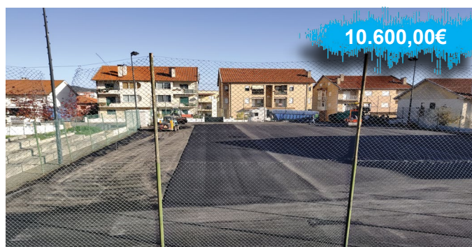
Início da construção do campo de padel e basquetebol
