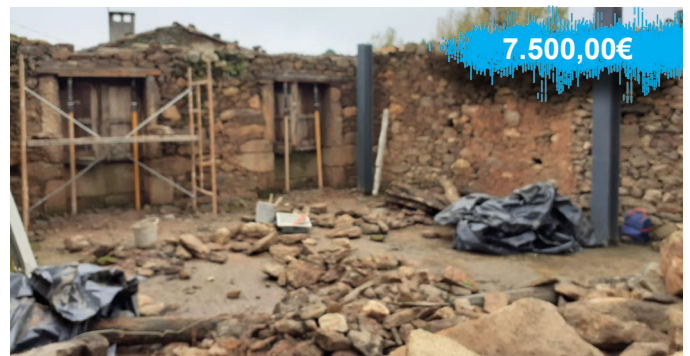
Requalificação de Edifício - Lamalonga.
