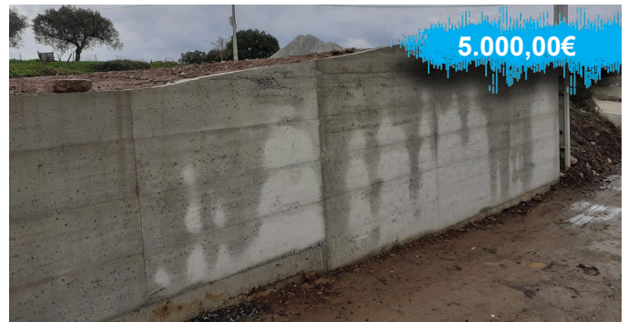
Construção de rampa para cargas e descargas na Freguesia de Vilarinho de Agrochão
