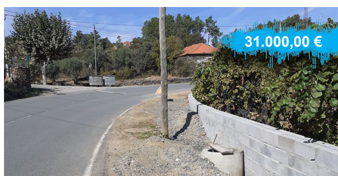
Drenagem de águas pluviais da EN216, em Peredo.
