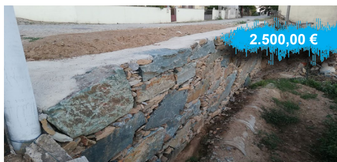
Reconstrução do Muro de Suporte de Terras, em Podence.
