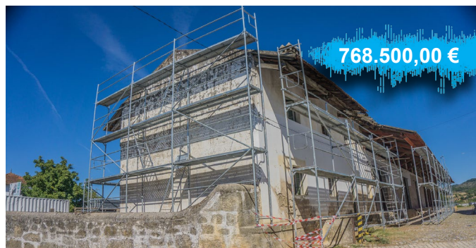
Reabilitação da Estação Ferroviária de Macedo de Cavaleiros.
