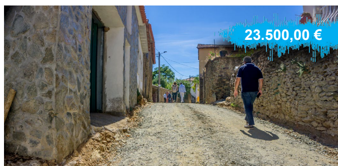
Pavimentação da R. Santo António e Travessa da Igreja em Chacim.
