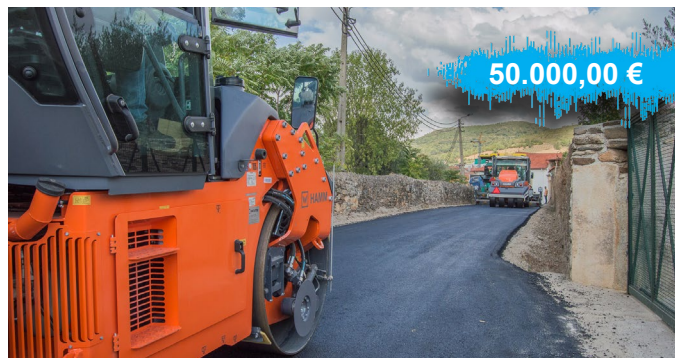
Pavimentação da EM573, Cortiços.
