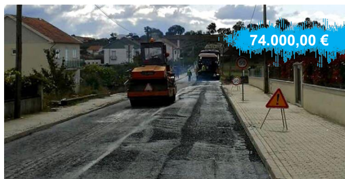
Pavimentação em Vilarinho de Agrochão.
