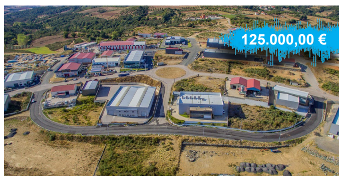
Infraestruturas na Zona Industrial de Macedo de Cavaleiros – Pavimentação do Eixo Secundário 6 e Infraestruturas nos Eixos Secundários 6 e 7.
