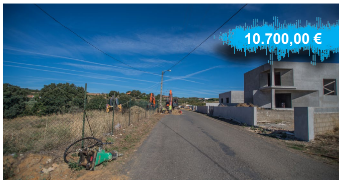
Abastecimento de água à EN102.
